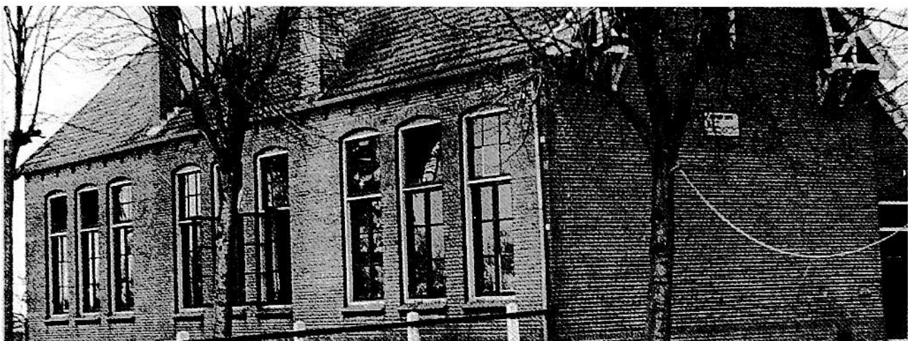
In 1903 werd in Hoogersmilde een vereniging voor christelijk onderwijs opgericht, op 1 mei 1911 werd de school geopend. Op de foto het oorspronkelijke gebouw.
